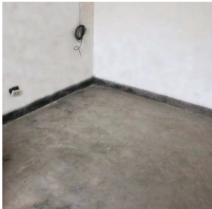
图 6 危险废物暂存间内部
